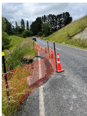
Pourerere Road RP16.73
