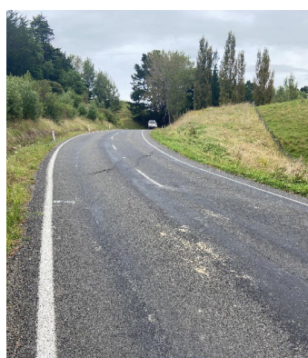
Pourerere Road RP15.263
