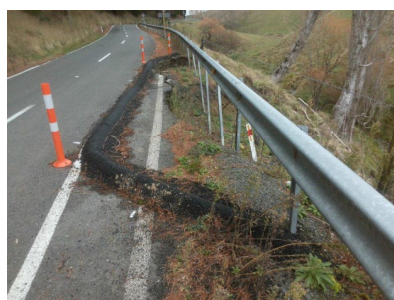
Pourerere Road RP26.292
