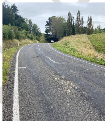
Pourerere Road RP15.263
