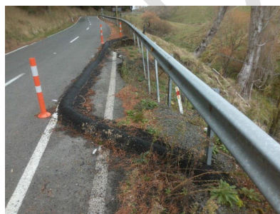
Pourerere Road RP26.292
