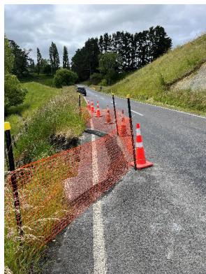
Pourerere Road RP16.73
